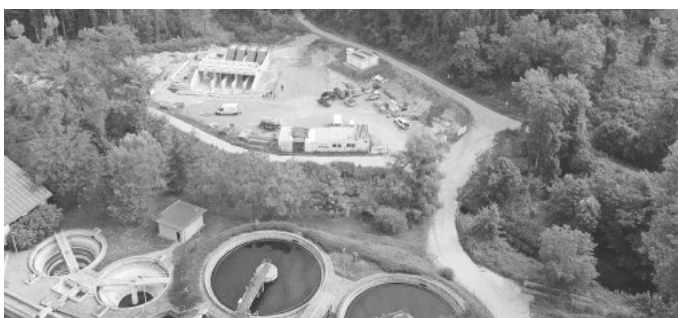
Foto: Das neue Pumpwerk an der Blauwasser in Burkheim von oben. Foto: Regierungspräsidium Freiburg
